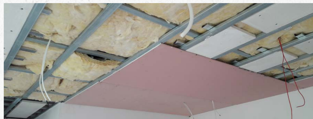
Zakładanie modułu sufitowego
